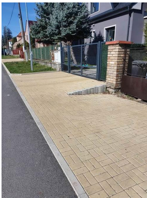
(Komunikace – asfaltový povrch, silniční betonová obruba, vjezd)
