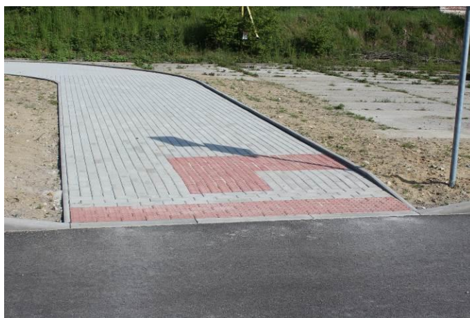
(Prvky pro slabozraké a nevidomé – místo pro přecházení, přirozená vodící linie – parkový betonový obrubník nášlap + 6 cm)
