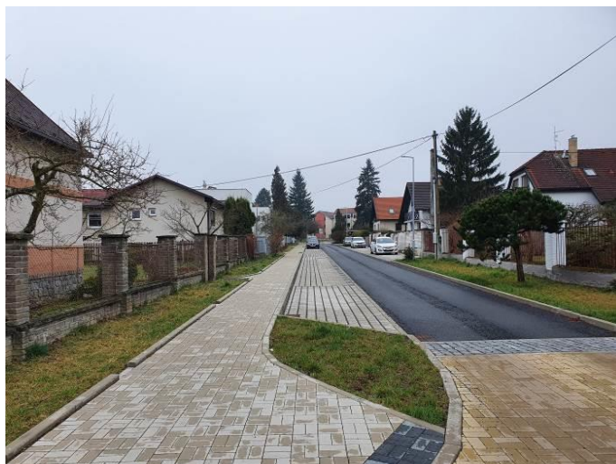
(Parkovací stání – dlážděný betonový povrch – distanční dlažba)
